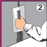
Выровняйте основание. Владины, трещины и неровности до 10 мм выровняйте клеем для плитки БОЛАРС «Стандарт», выше 10 мм – штукатурными составами БОЛАРС.
